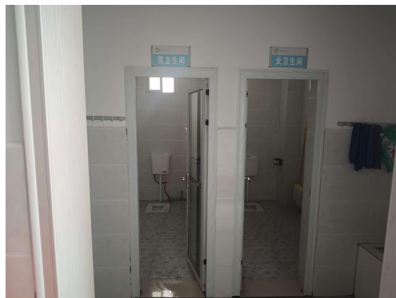
介入手术室内正上方（二楼厕所）
